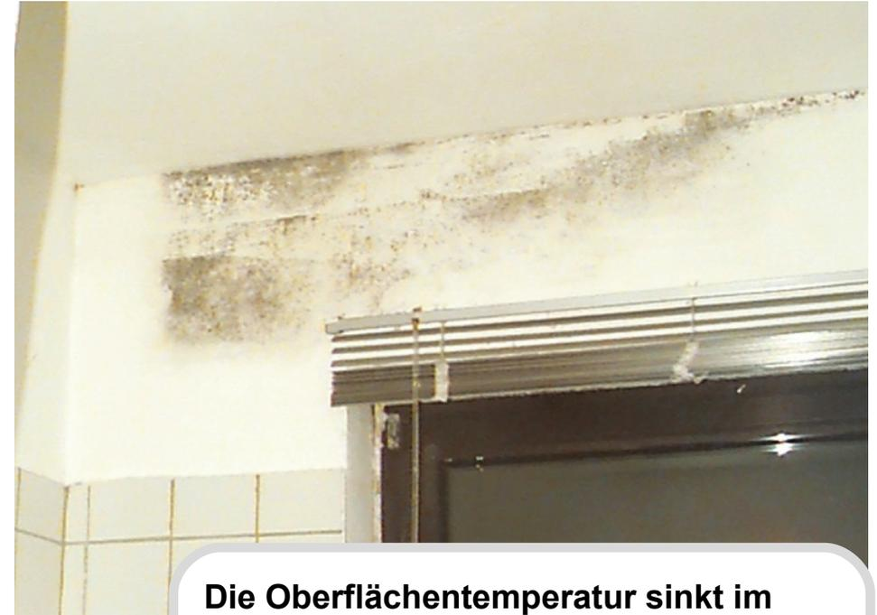
Die Oberflächentemperatur sinkt im Bereich der Wärmebrücke bei niedrigen Außentemperaturen ab, die feuchte Innenraumluft kondensiert an der raumseitigen Bauteiloberfläche.
